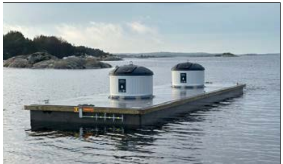
FRIGIR TID Fredrikstad har fått på plass to flytende dypoppsamlere – en på Geitøya og en på Torsnes. Tiltakene reduserer søppel på avveie, gir mindre lukt og frigir ressurser til andre oppgaver.
