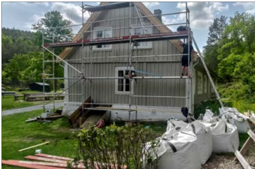
REHABILITERING AV TAK Gamlegården på Håøya er en av flere hytter som har fått et større løft, og i fjor ble taket rehabilitert takket være støtten fra Sparebankstiftelsen DNB. Gamlegården er en av mange hytter med gamle materialer det er verd å ta vare på og sette i stand der det er mulig. Det eldste intakte vinduet på hytta har håndlaget glass fra slutten av 1700-tallet.
